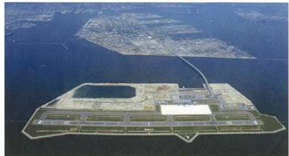
神戸空港 平成18年開港時
