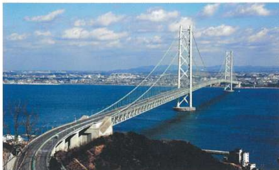
淡路側より望む「明石海峡大橋」
