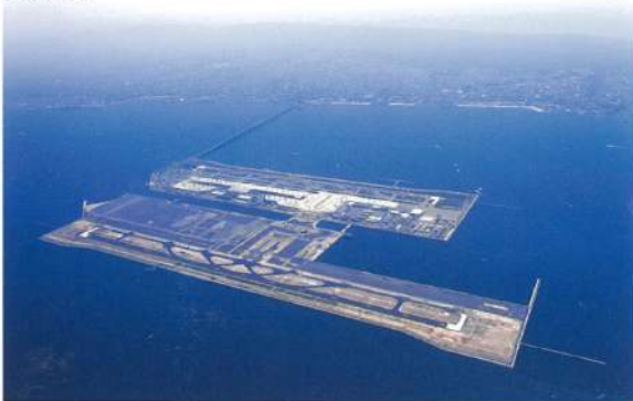
関西国際空港 第二期工事
