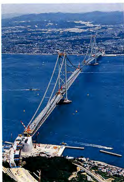
■ 工事中の明石海峡大橋 写真提供： 本州四国連絡橋公団
