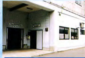
X 津居山油槽所
