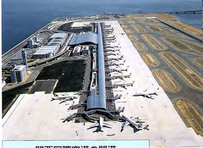
■関西国際空港 写真提供： 関西国際空港株式会社
