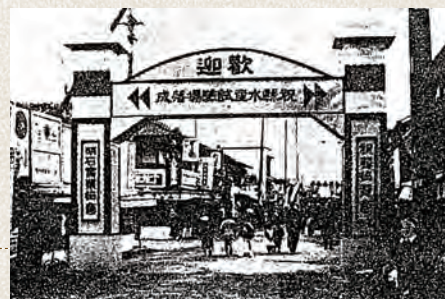
▲県水試完成歓迎アーチ
