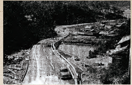
▲うずしおラインと伊弉漁港直結道路完成
