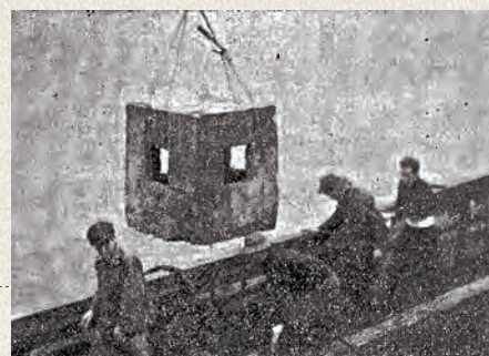
▲コンクリート魚礁設置試験
