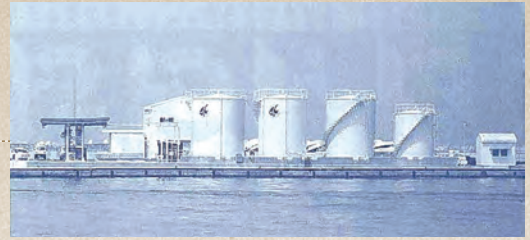
▲県漁連育波油槽所完成
