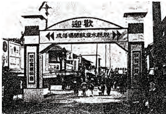
▲県水試完成歓迎アーチ
