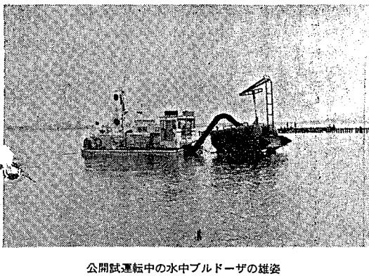
公開試運転中の水中ブルドーザの雄姿
