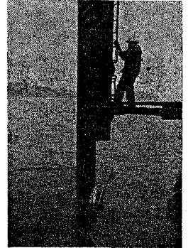
鋼管パイルの打込み(径45cm)
