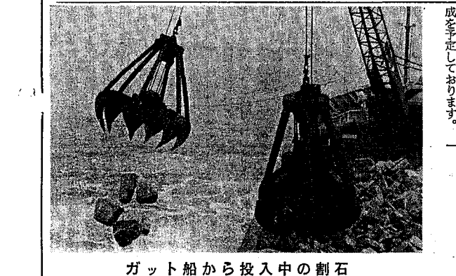
ガット船から投入中の割石
