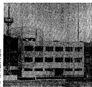
竣工なった香住海上保安署新庁舎
