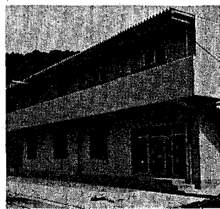
(写真) 資材倉庫および漁具倉庫施設(岩見漁協)
