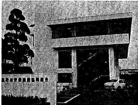
新設なった伊保漁協事務所
