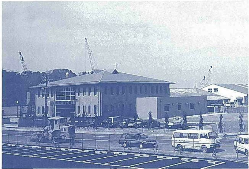
完成した但馬栽培漁業センター
