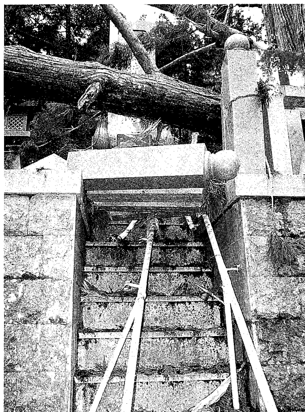
巨木が倒れかかる「漁友鎮魂の塔」への石段
