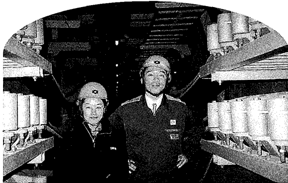
南港火力線の地中送電線に感激
