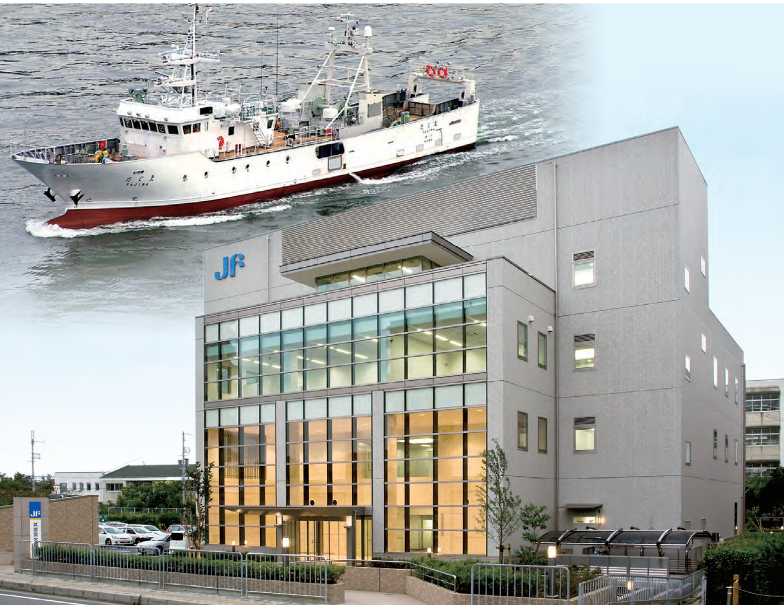
7月に竣工した兵庫県水産会館と調査船「たじま」
