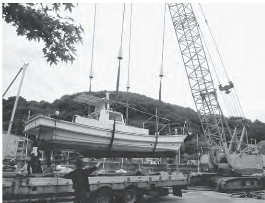
慎重な作業で積み込みます
