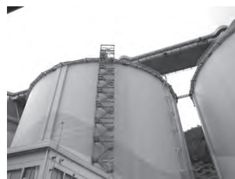
大きさに驚いた“石炭サイロ” (直径60m、高さ80m)
