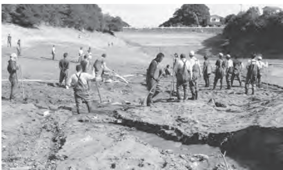
ポンプによる放水作業
