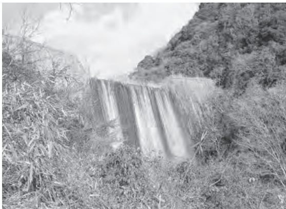
六甲山系119番目に建設された「五助堰堤」(不透過式)
