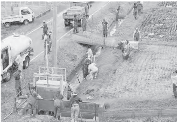
用水路では、池からの泥を流しつつ、魚を救出!
