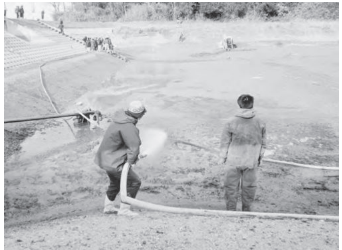
放水で泥を流します
