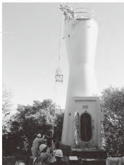
旧灯ろうを撤去中の生石鼻灯台
