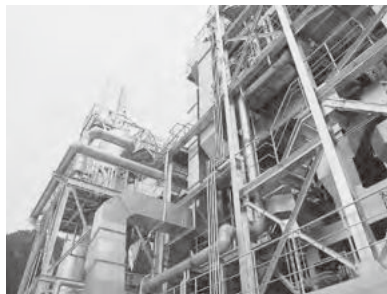
12月から稼働するバイオマス発電所
