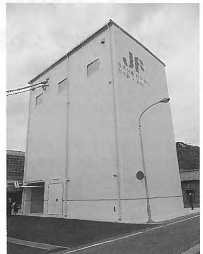
自動製氷貯氷搬出施設外観
